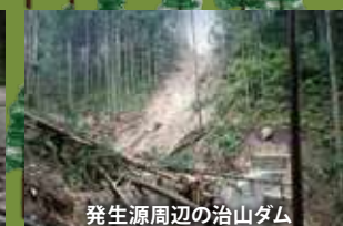
発生源周辺の治山ダム
